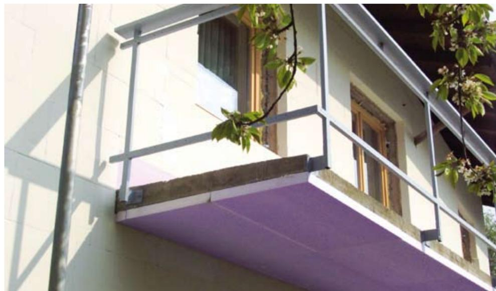
Fehlerhafte Außendämmung an den Fensterleibungen und an der Balkonplatte
